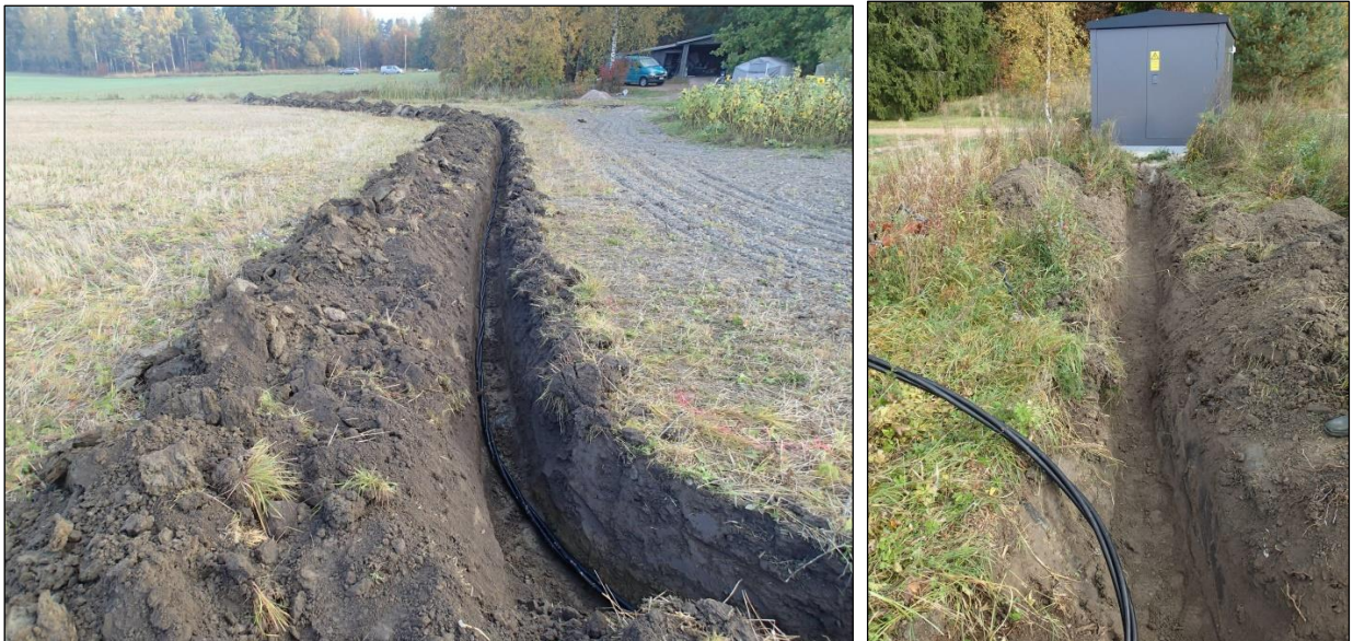
Vasen kuva: linjan läntisin kohta. Etelästä. Oikea kuva: kaivannon peruslinjasta muuntajalle tehty erillinen linjanosa. Etelästä.
