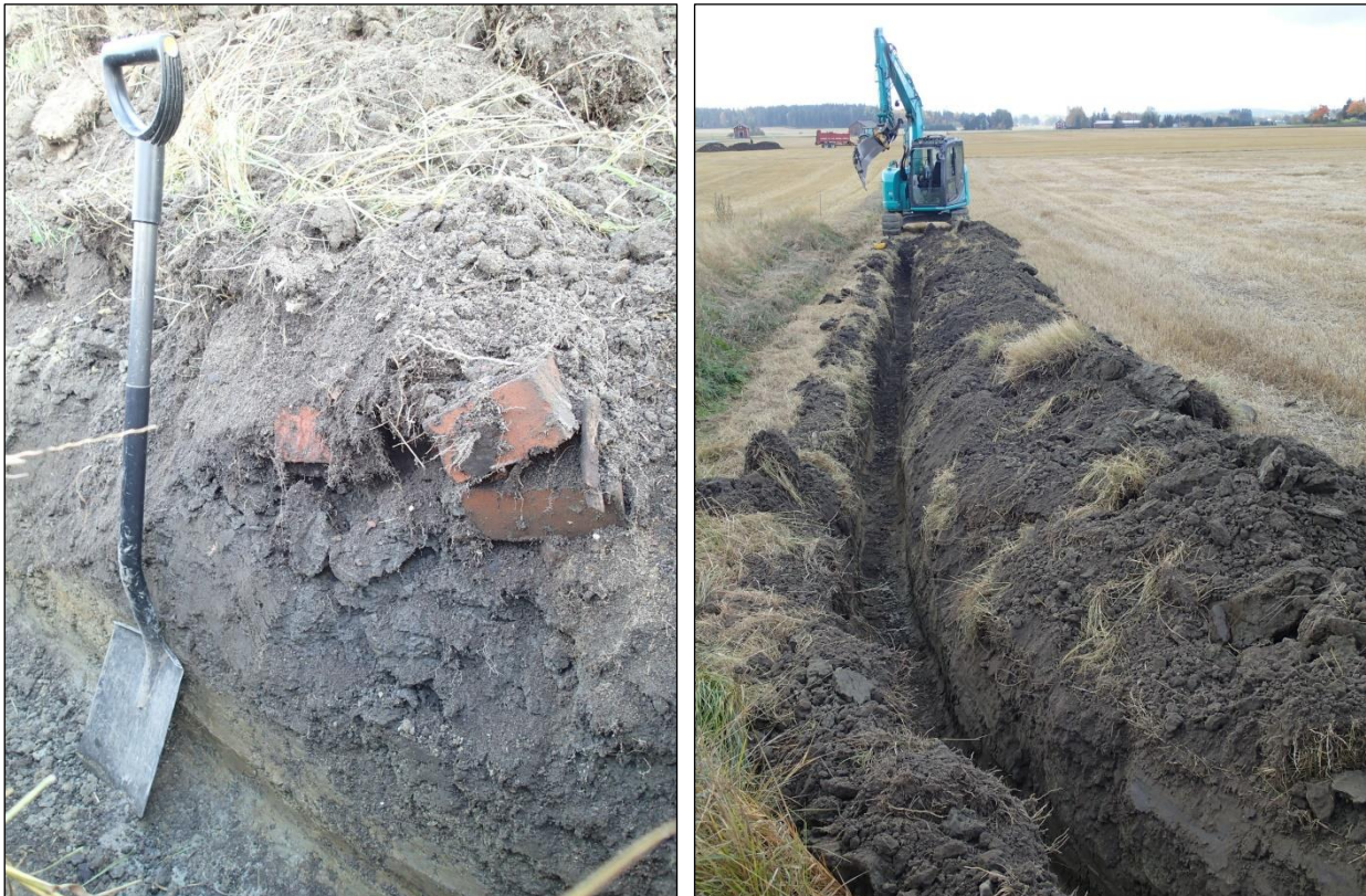
Vasen kuva: tiilenkappaleita ym. paksusti sekoittuneessa maassa muuntajalle tehdyn erillisen kaivannon osan ympäristössä. Oikea kuva: valvotun linjan viimeinen eli eteläisin osa. Kaivinkone on valvotun osuuden päätepisteessä. Koillisesta.
